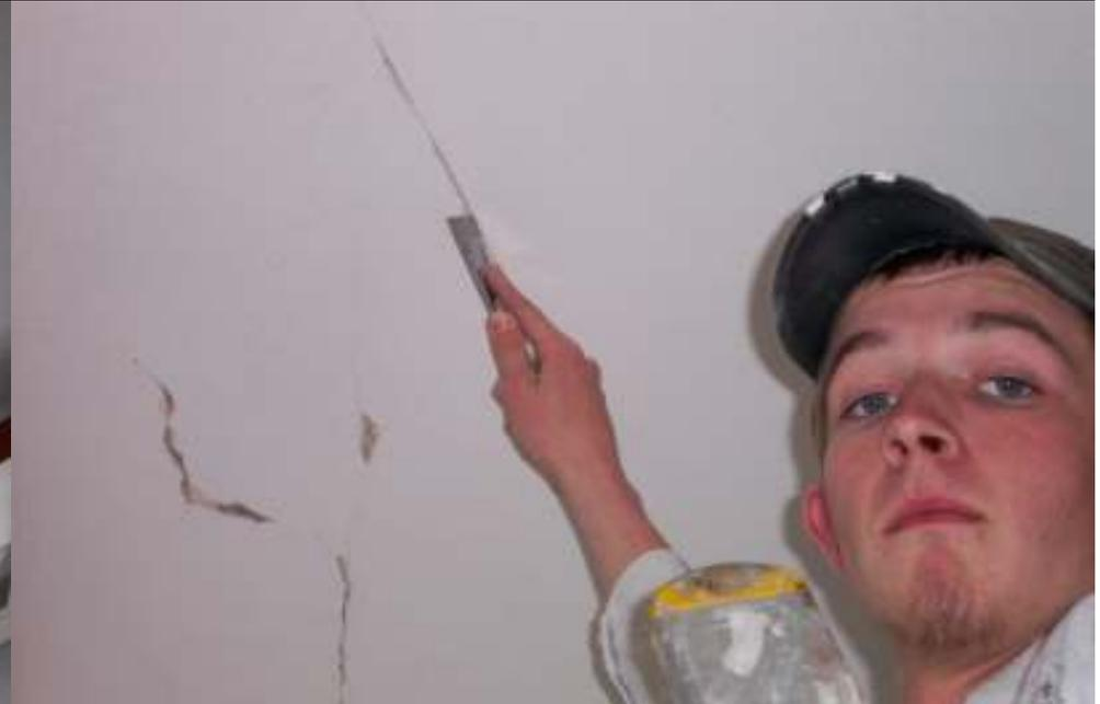
*Um die Risse besser verfüllen zu können, werden diese durch leichtes Aufkratzen mit dem Spachtel geweitet, um sie dann wieder neu und besser verfüllen zu können*
