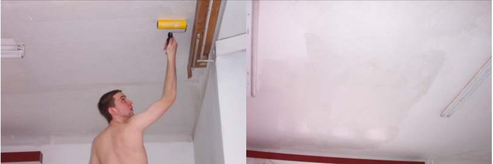
*Die Risse werden nun mit Gewebe, das in Gewebekleber eingebettet wird, überbrückt, um eine weitere sichtbare Rissausdehnung zu vermeiden.*
